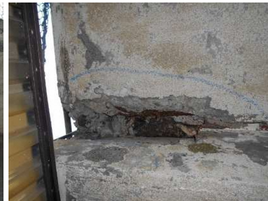
コンクリートの剥落、欠損
