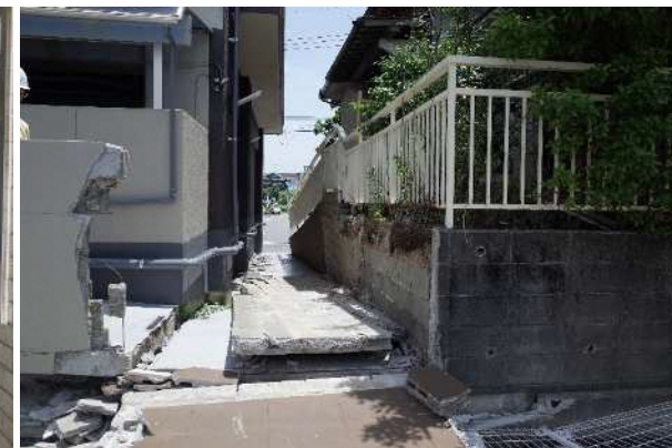
ブロック塀が倒壊したマンション
