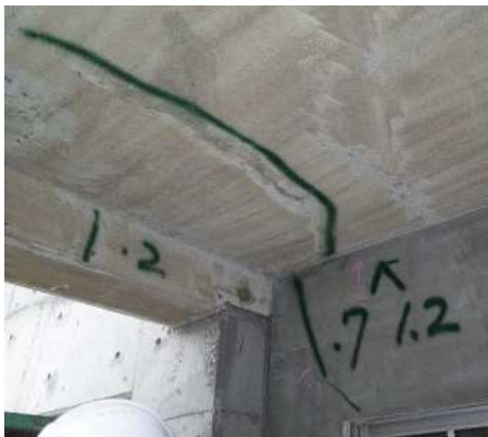
コンクリート躯体のひび割れや中性化
