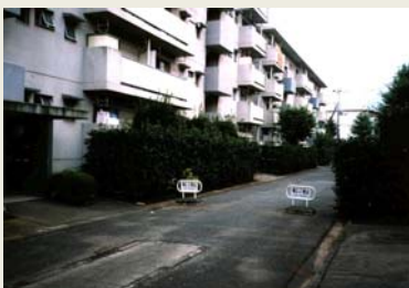
団地内通路改修前
