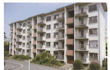
RCラーメン構造棟
